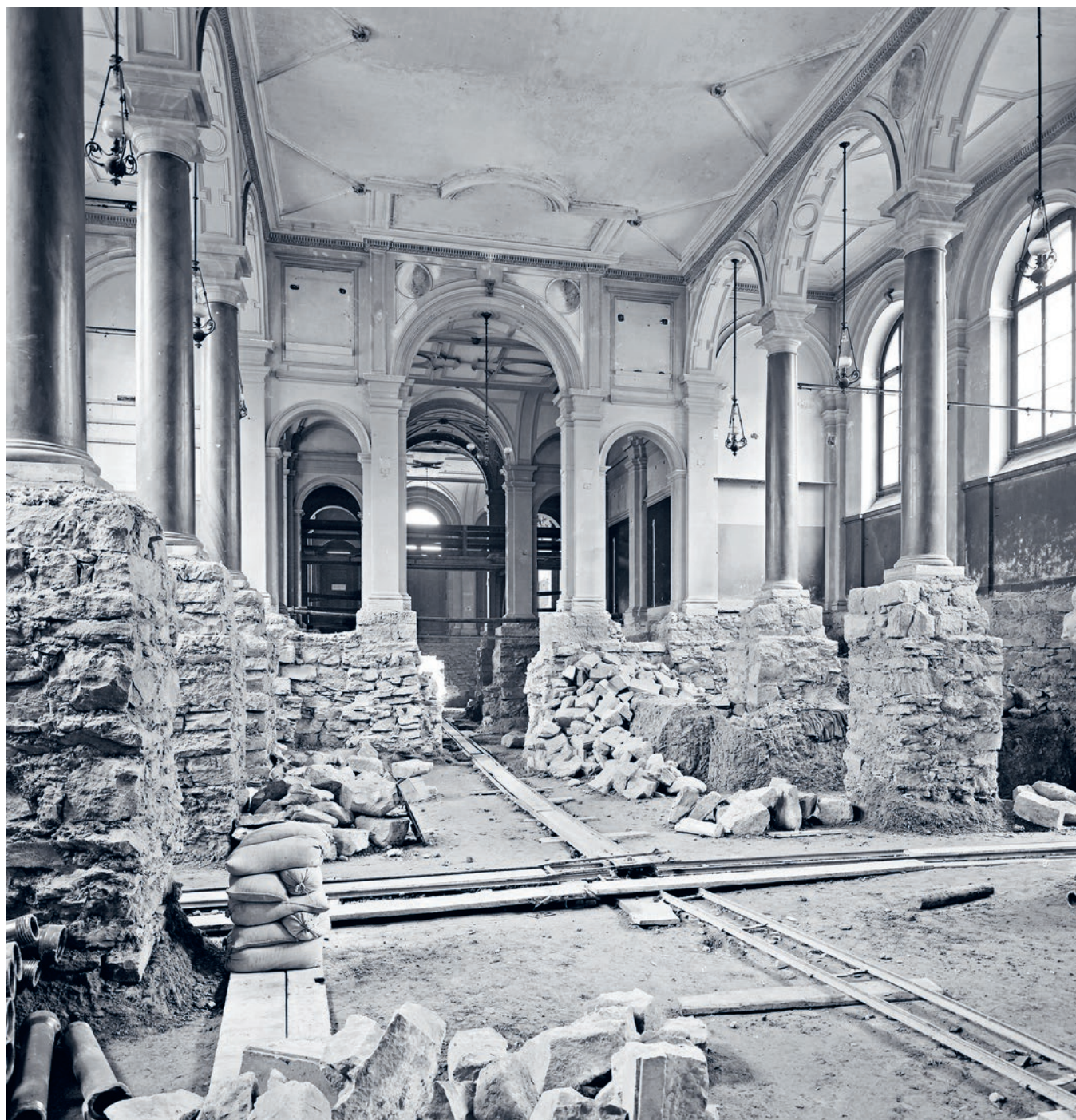
Blick auf die Haupthalle der ETH Zürich während des Umbaus durch Gustav Gull (1915).
